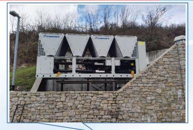
Progettazione efficientamento energetico mediante installazione di pompe di calore in serie. Potenza installata oltre 500 kW ed ottenimento contributo Conto Termico 2.0
